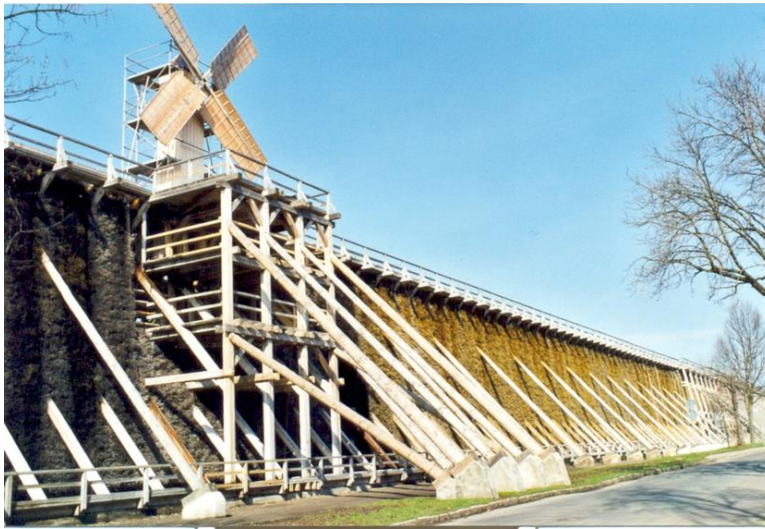
Gradeerwerk ten behoeve van de zoutwinning
